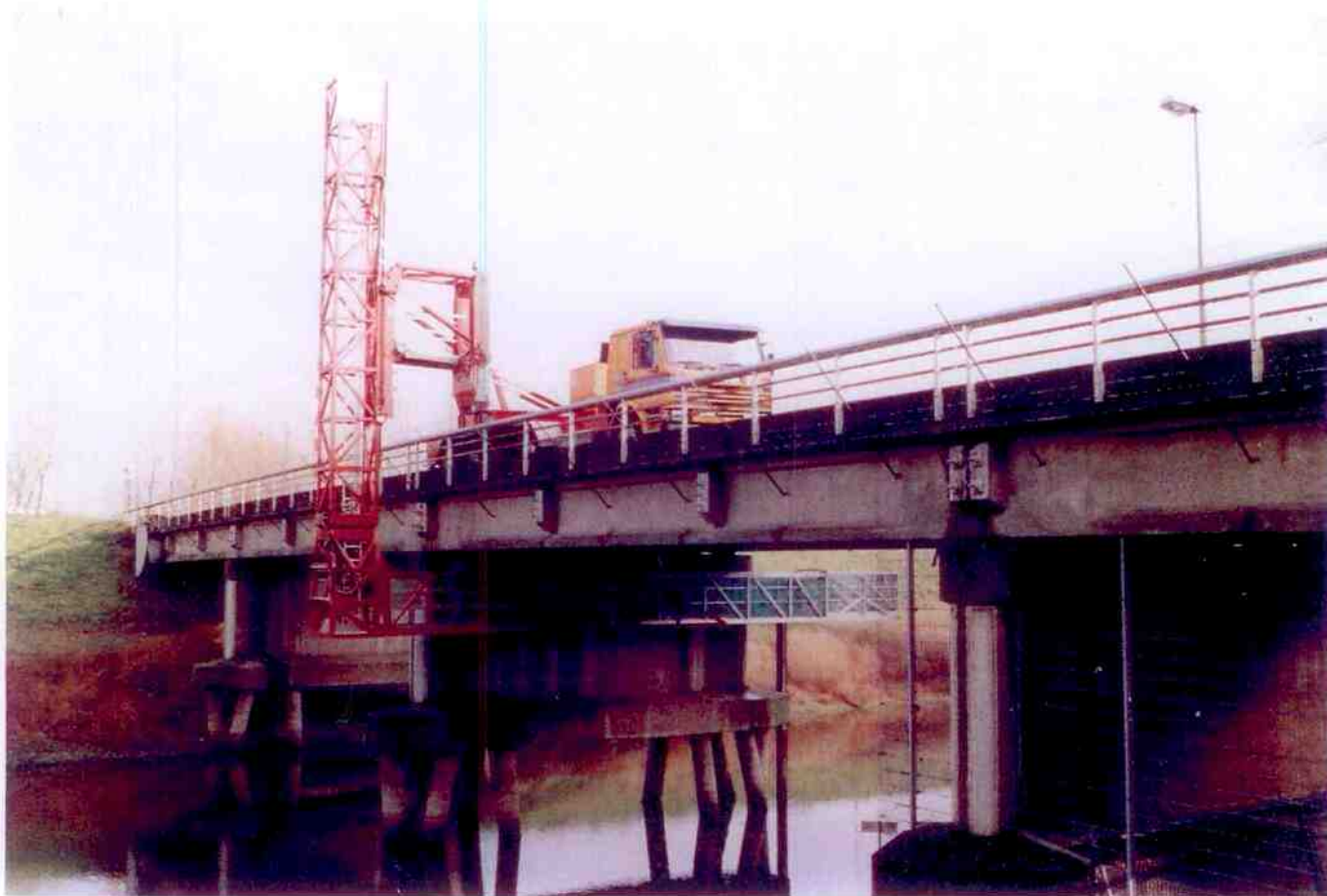
Inspectie van de toegangsbrug.
